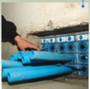
FTTH: Conductos de fibra óptica de la red en los cimientos de la caseta.
