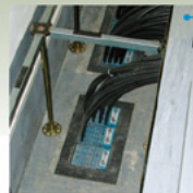
Centros de comunicaciones: Sellado de fibra óptica y cables en suelos y paredes exteriores.
