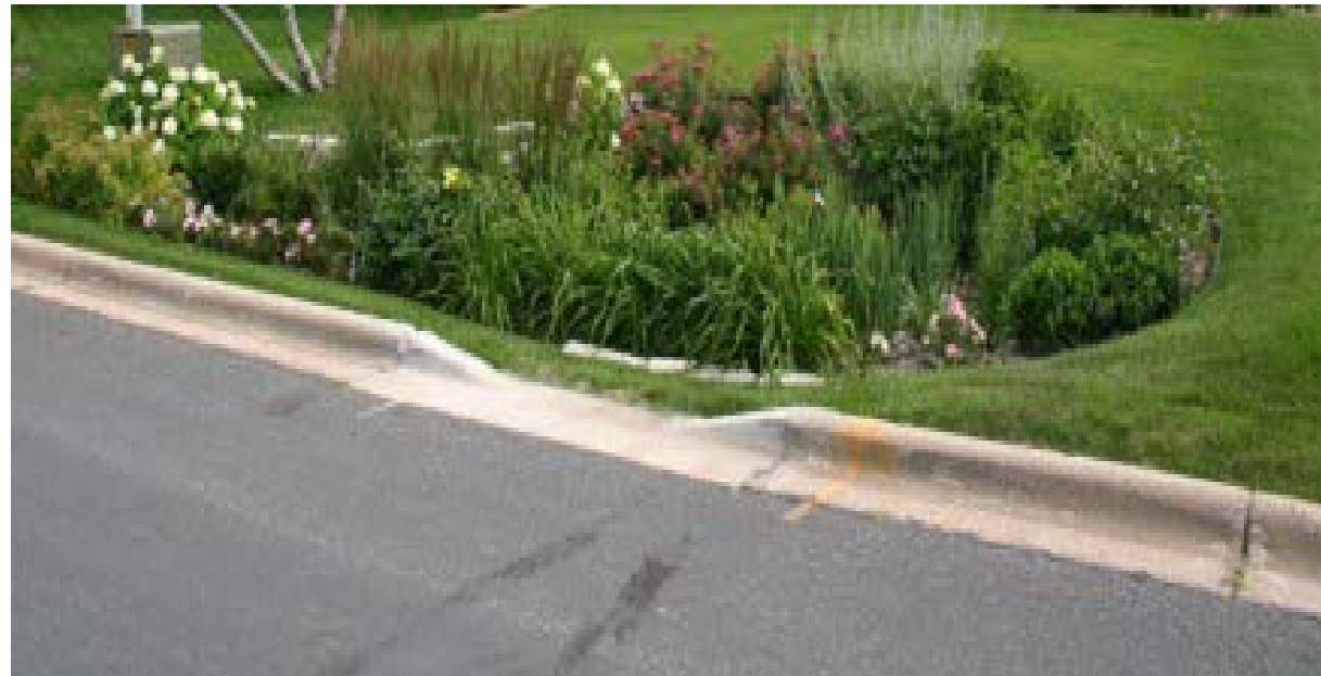
Foto: Jardín de lluvia en una zona residencial. Crédito de la foto: EPA
